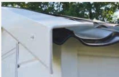
Détail : profil de rive en acier laqué avec embout caoutchouc
