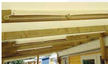
Fixations intermédiaires du **toit STANDARD** avec sandow et poulies. Etanchéité avec bavette arrière dans la gouttière
