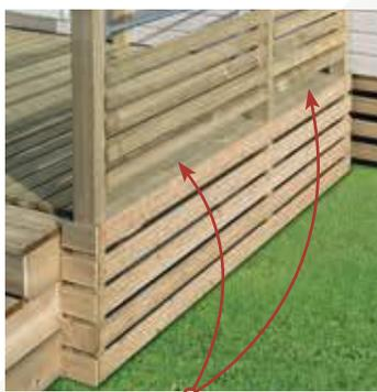
Détail côté avec lattes de finition entre les poteaux
