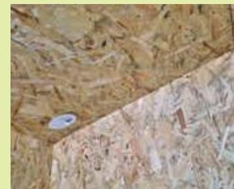
Finition intérieure avec plafond en OSB3 et grilles de ventilation
