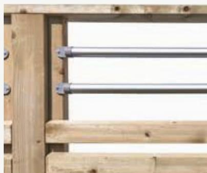
Détail rambarde avec main courante à plat
