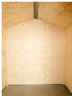
Structure ossature en sapin du nord (ép. 40 mm) et finition intérieure bois (contre-plaqué finlandais ép. 10 mm). L'élégance naturelle du contreplaqué apporte chaleur et authenticité.
