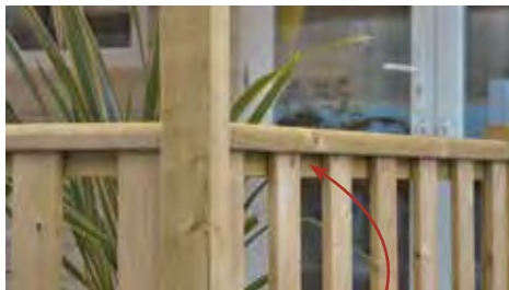
Détail traverse sous main courante
