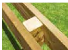
Cale de renfort sur piètement intermédiaire. Profondeur 3m.
