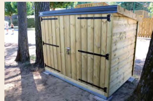
Bardage et porte traités en bois autoclave
